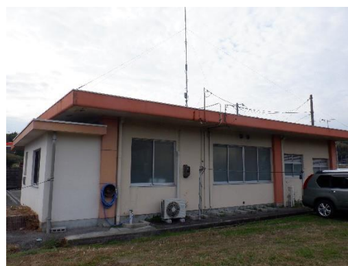
現庁舎東側外観
