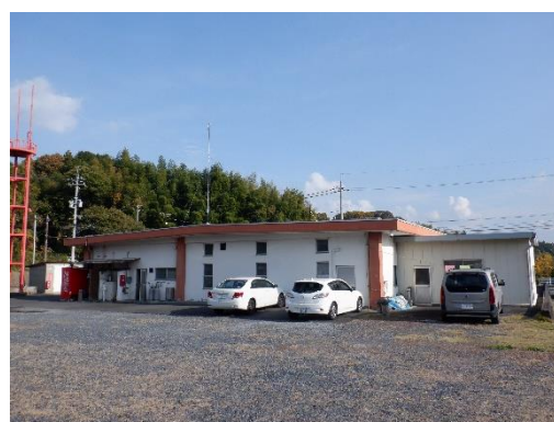
現庁舎北側外観
