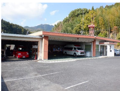
現庁舎南側外観
