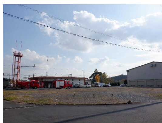
敷地南側の現況
